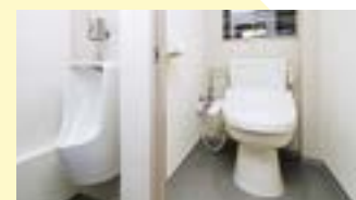
従来型は小便器と個室洋式便座を設置。「RE / BIO」では個室に加え、浄水システム搭載のシンクが設置される
